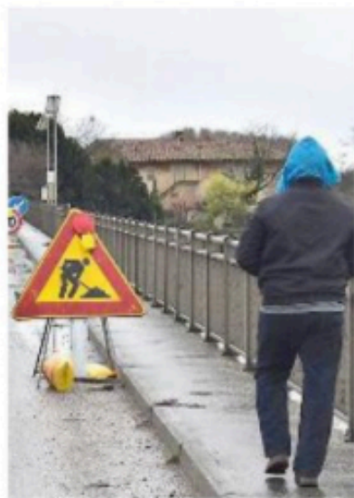
PUNTO CRITICO Il ponte sullo Scolmatore dopo l'incidente
